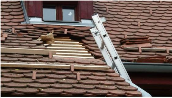
Beim Dach des Ökohofs wurde ein alter Baufehler ausgebessert, so dass jetzt nach vielen Jahren kein Wasser mehr in die Isolationsschicht rinnt.
